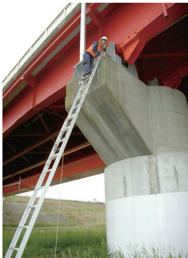
TSによる橋脚の変位測定
