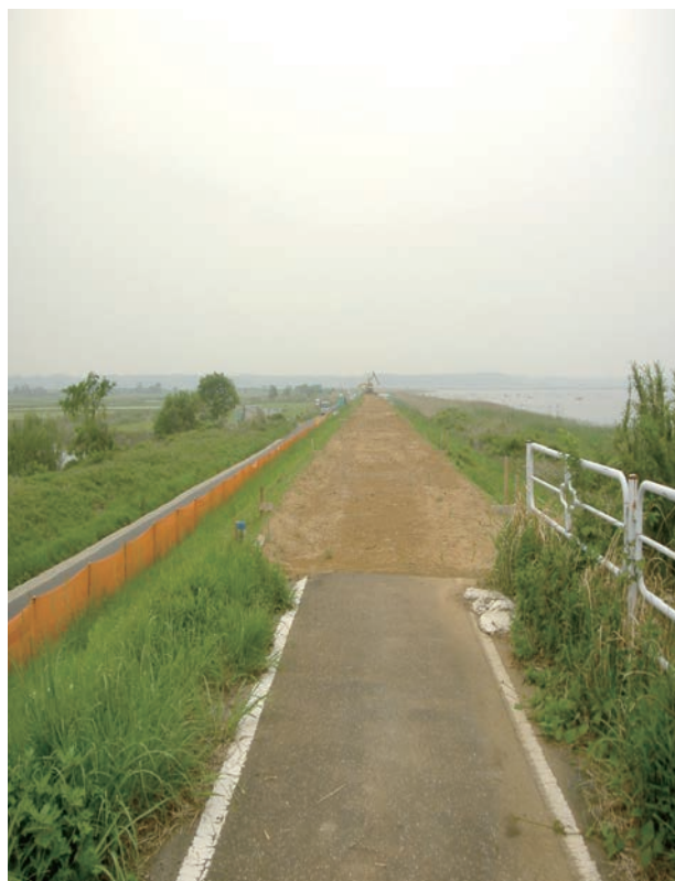
応急工事後 平成24年5月撮影（当社撮影） 左写真と同じ場所
