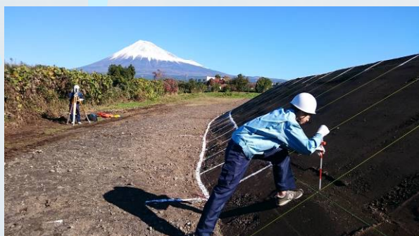
現場計測の様子
