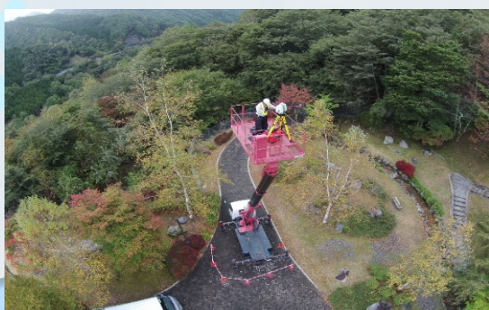
高所作業車での3Dレーザ計測
