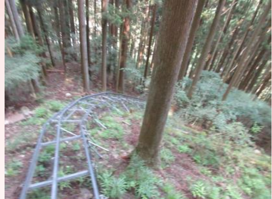
モノレールの線路
