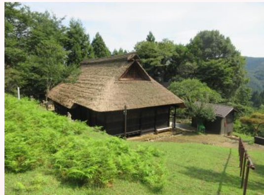
小林家住宅(背後斜面から)
