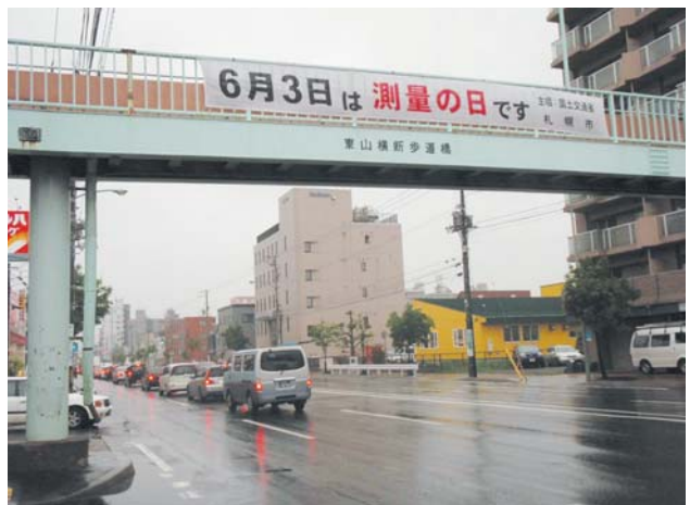
札幌市 東山歩道橋
