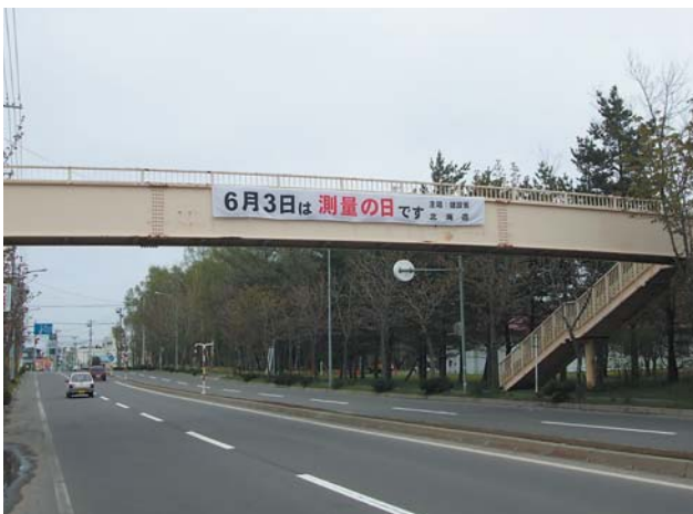
北海道 帯広建設管理部
