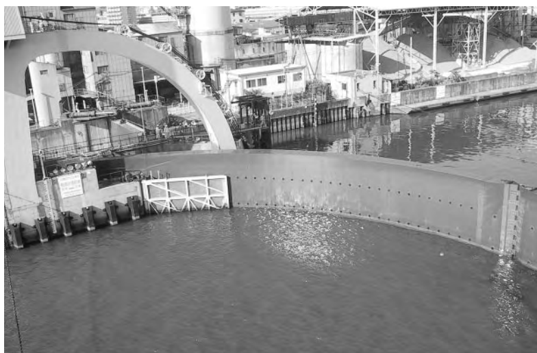
水門閉鎖完了(試運転)
