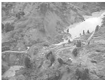
斜面崩壊やこれに伴う河道閉塞 箇所の把握
