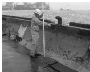
港湾の被災状況調査
