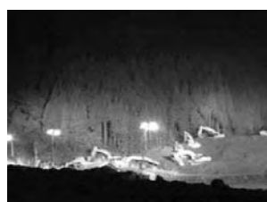
照明車による夜間作業支援
