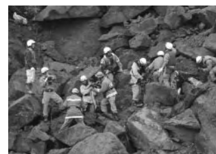
専門家による法面の監視及び作業の安全性に関する助言
