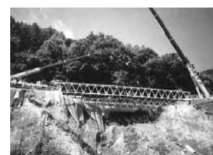
応急組立橋による道路通行
