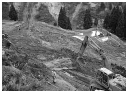
遠隔操作によるバックホウ作業
