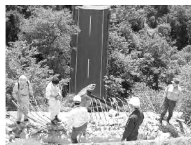
橋梁の点検状況 国道342号祭時大橋（岩手県一関市）
