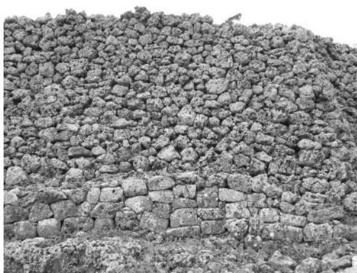
写真3 下部は布積み、上部は野面積み
