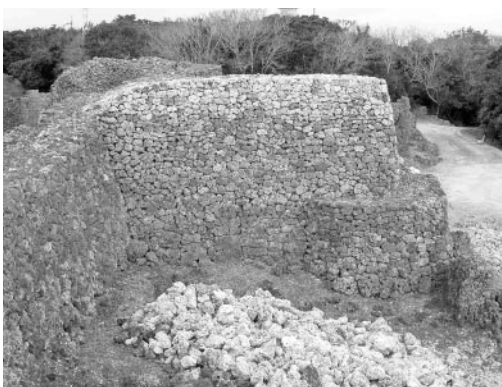
写真4 雉の先端に補築
