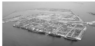
夢洲コンテナターミナル
