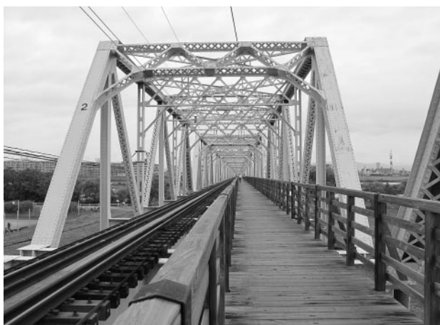
赤川鉄橋の木製歩道橋
