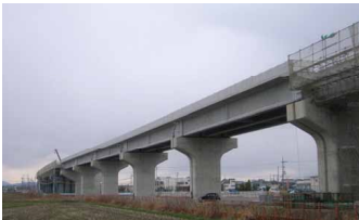
工事が進む大和御所道路（奈良県柏原市）
