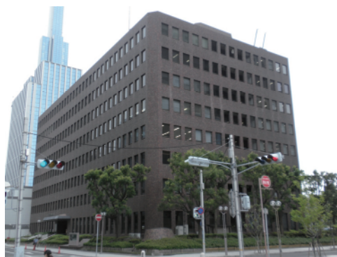
神戸地方合同庁舎(免震改修)
