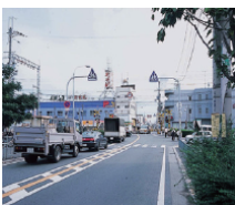
■鉄道の連続立体交差事業
