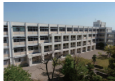
■校舎の耐震改修
