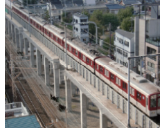
(下り線高架切替完了)
