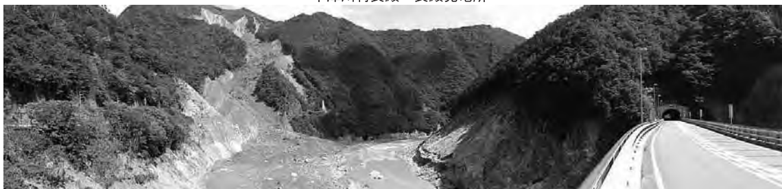
十津川村 濁谷崩壊
