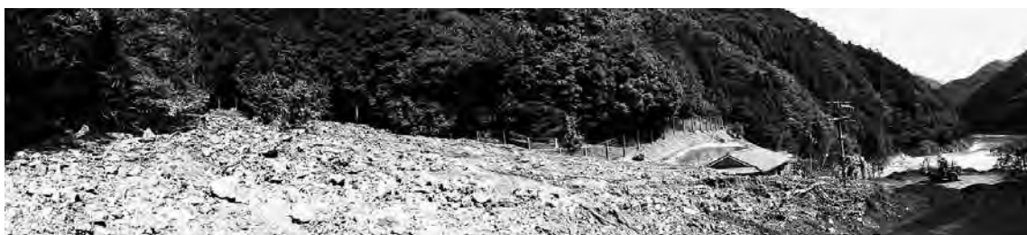
十津川村長殿地区 被災状況
