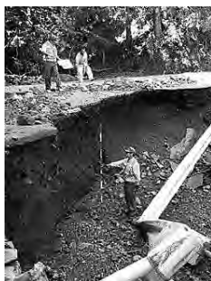
被災状況調査
