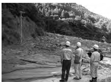
孤立集落アクセスルート被災箇所調査
