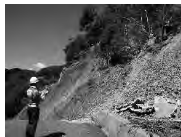
十津川村周辺の地すべり等の 被害状況をTEC-FORCEが調査
