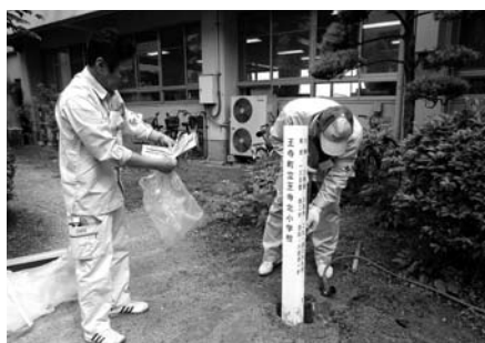
写真は平成23年度建植中の標柱です。
