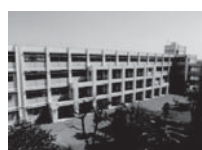
■校舎の耐震改修
