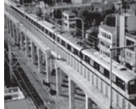
(下り線高架切替完了)
