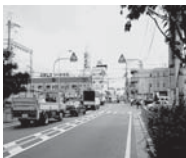
■鉄道の連続立体交差事業
