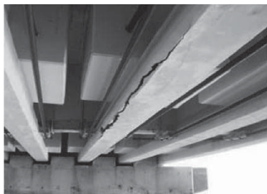
主桁のひび割れ（一般国道42号 古座大橋）
