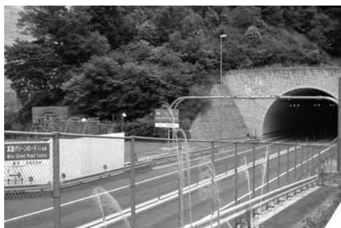
(箕面グリーンロードトンネル)
