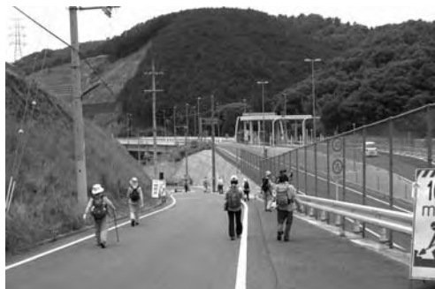
(新名神高速道路工事中)
