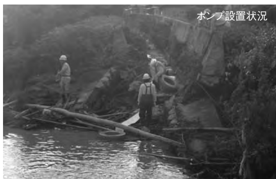
弥陀次郎川堤防の決壊箇所の排水作業
