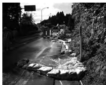
排水先の状況
