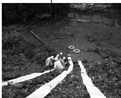
ポンプ設置状況(湛水池)
