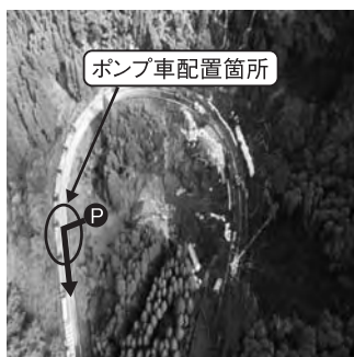
上空からの現場
