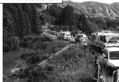
ポンプ車配置状況
