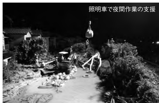
弥陀次郎川堤防の決壊箇所の排水作業
