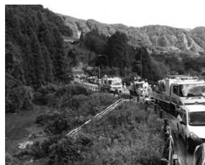
ポンプ車配置状況
