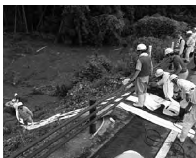
ポンプ設置状況
