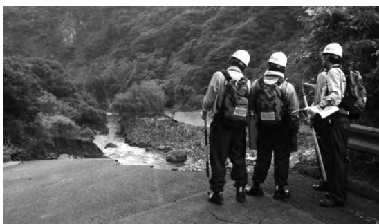
村道崩落箇所の調査
